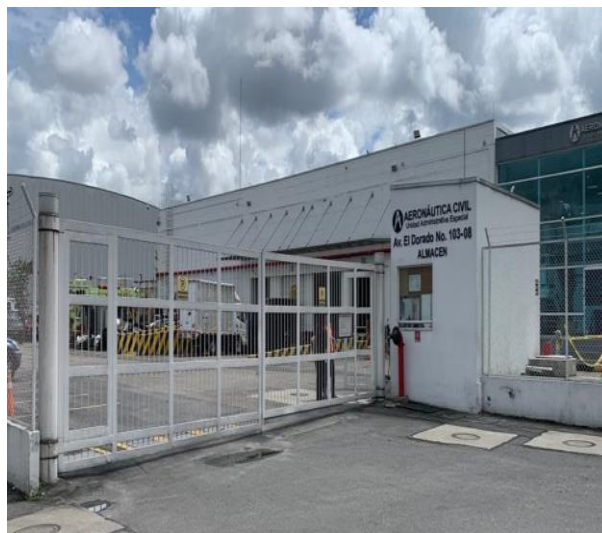
Fotografía 3. Nuevo Almacén De La Aeronáutica Civil (NAA)
