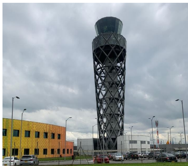
Fotografía 1. CGAC-Torre de control
